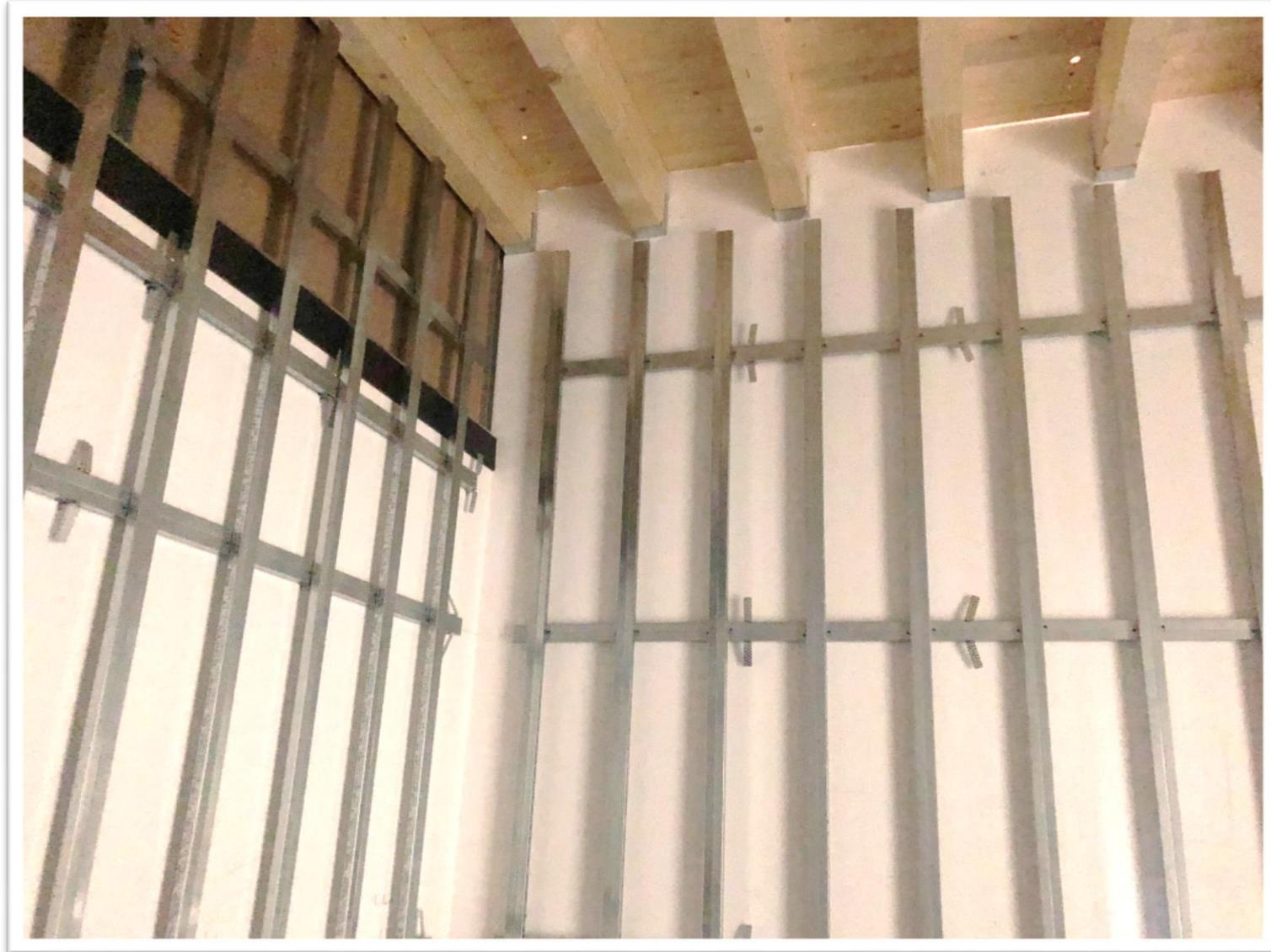
17. April 2020 – Einbau der Zwischendecke und der Alu-Rahmen für die Klimawände
